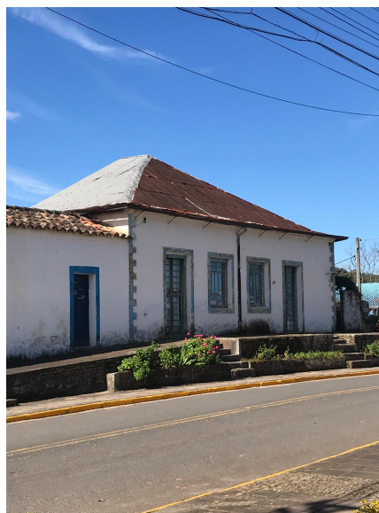
Figura 26. Edificação histórica com calçadas altas fonte: Mariana Mincarone
